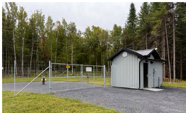
Nouveau puits #4: Construit dans le 4e Rang Sud, ayant été présenté lors de la Tournée des infrastructures d'eau publiques
