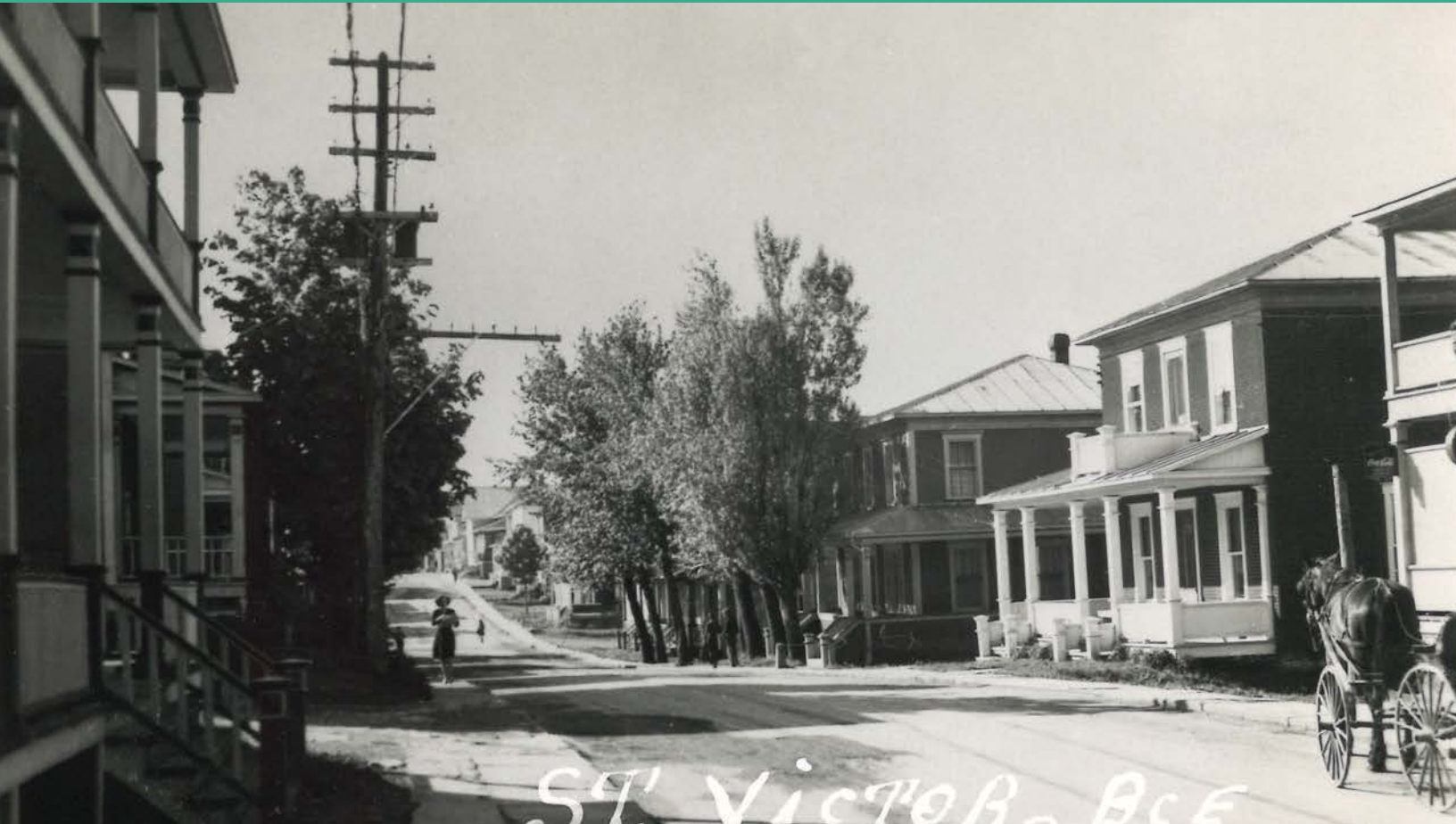
Rue Commerciale, la maison avec galerie blanche à située à l'emplacement du Salon funéraire Yves Bolduc. Fonds Mme Colette Couture | Avant 1948 | SPSVB
