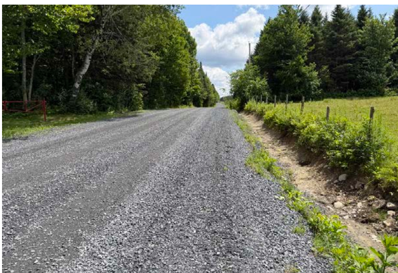
4 e Rang Nord: Creusage de fossés et rechargement effectués.
